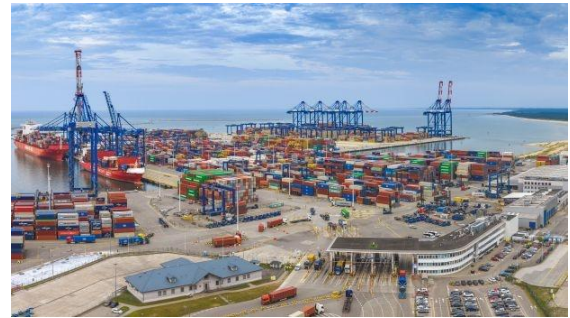
Baltic Hub ターミナルの遠景
